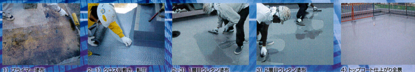
1) プライマー塗布
